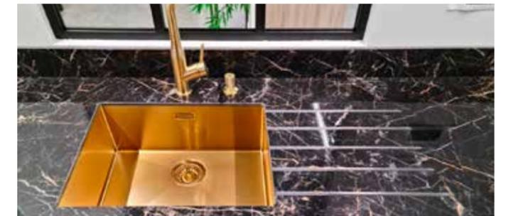
Afin d'installer des éléments affleurants une plaque métallique est installée en sous face du plan, ceci permet d'avoir un élément porteur. Un calage (non fourni) est nécessaire afin de régler la hauteur. Il est conseillé de laisser un jeu périphérique de 2 mm par rapport à l'accessoire.
